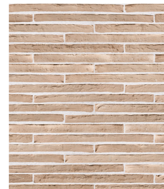
Parement de briques de réemploi longues appareillées
