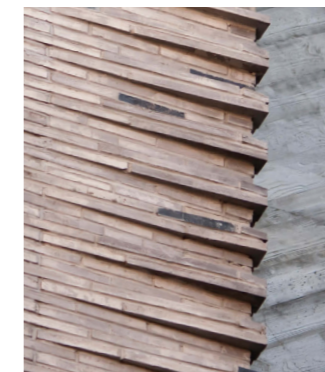
Traitement de l'angle avec retournement du parement
