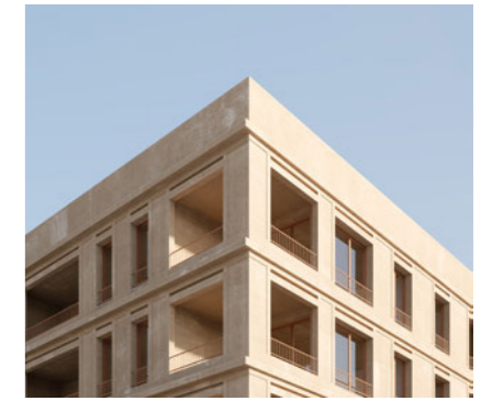
détail / Les engravures des façades participent comme les loggias à l'animation depuis la rue.
